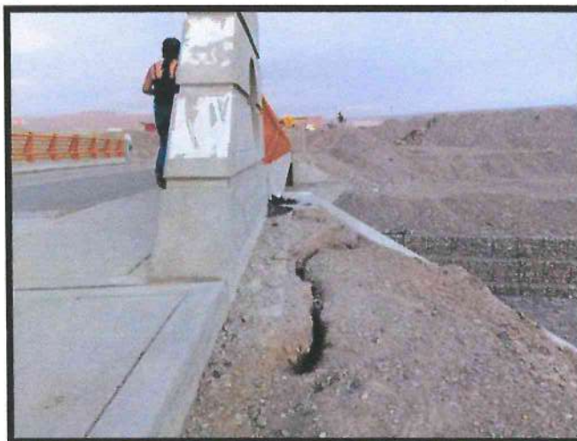
Imagen N° 5: Daños en compactación de Puente Pampa Colorada
