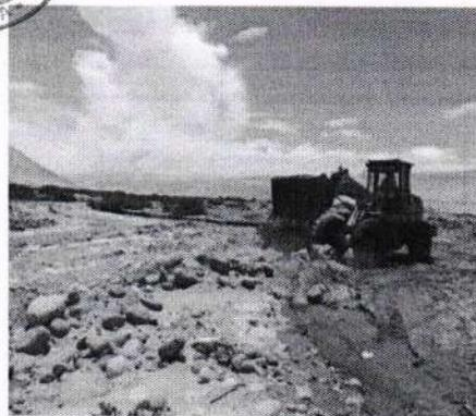
**Imagen 03:** realización de actividades mantenimiento del cauce de río seco mediante la limpieza, descolmatación y encausamiento para la prevención de avenidas en el Distrito Crnl. Gregorio Albaracín Lanchipa, Tacna-Tacna
