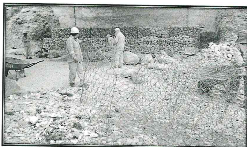
Reforzamiento del Puente Chastudal mediante la colocación de gaviones en el pilar central y sus respectivos estribos
