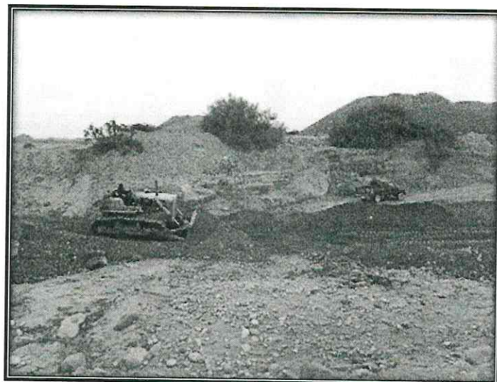
Encausamiento del Rio Chastudal con maquinaria pesada Tractor D7
