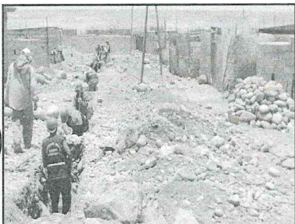
INSTALACION DE AGUA Y ALCANTARILLADO
